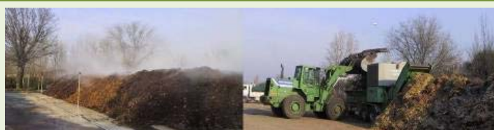
Planta de compostaje de Migas Calientes, Madrid
